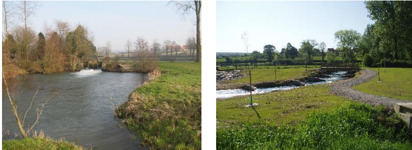
Ouvrage avant et après travaux
