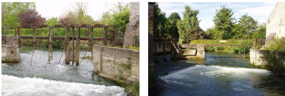
Ouvrage avant et après travaux
